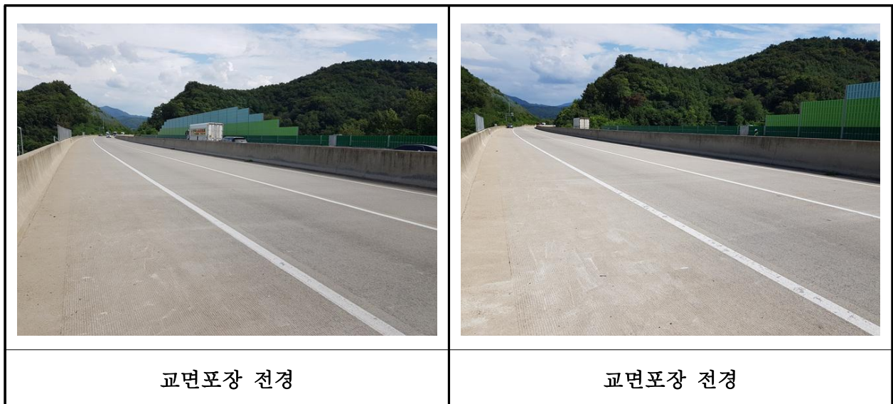
【사진 3.3.22】 교면포장 전경
