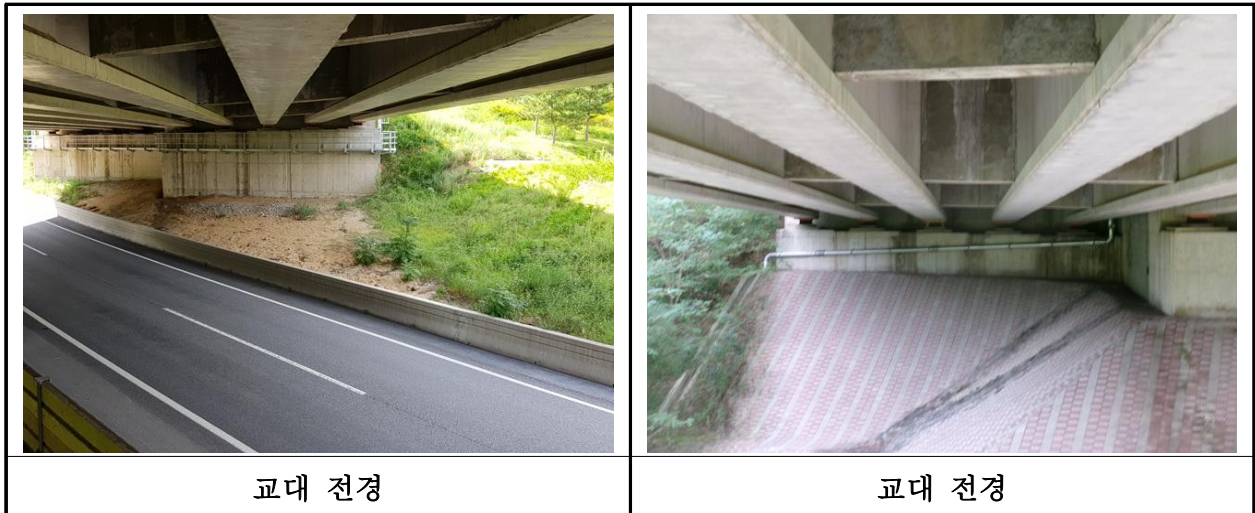
【사진 3.3.10】 교대 전경
