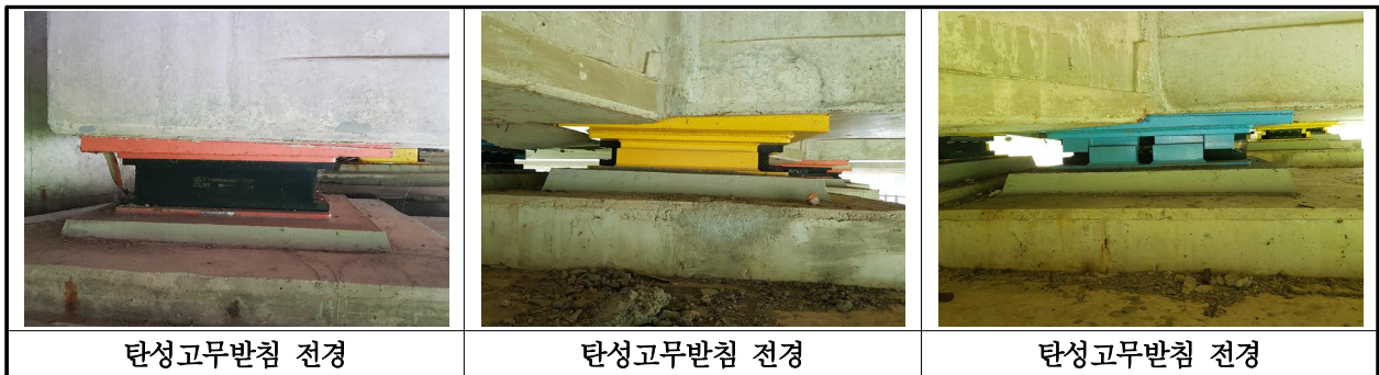
【사진 3.3.15】 교량받침 전경
