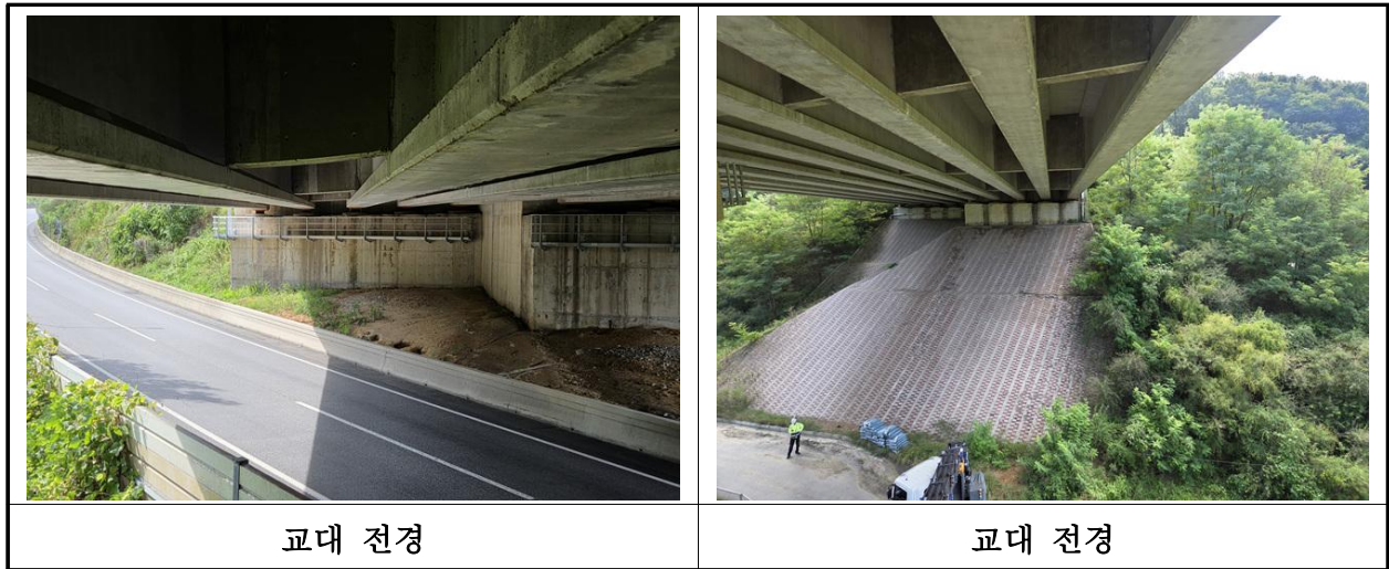
【사진 3.3.37】 교대 전경
