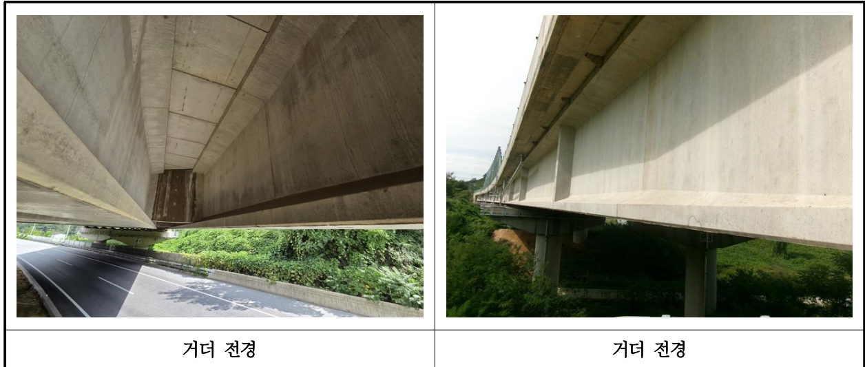
【사진 3.3.33】 거더 전경
