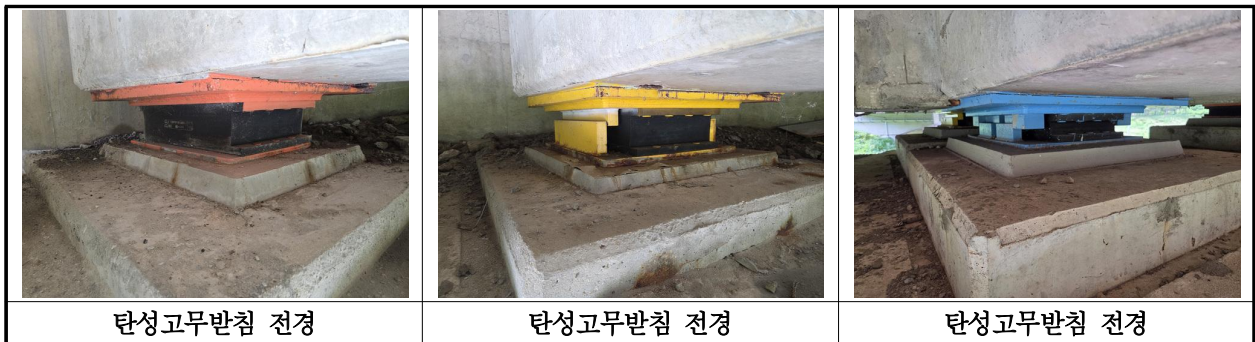
[사진 3.3.42] 교량받침 전경
