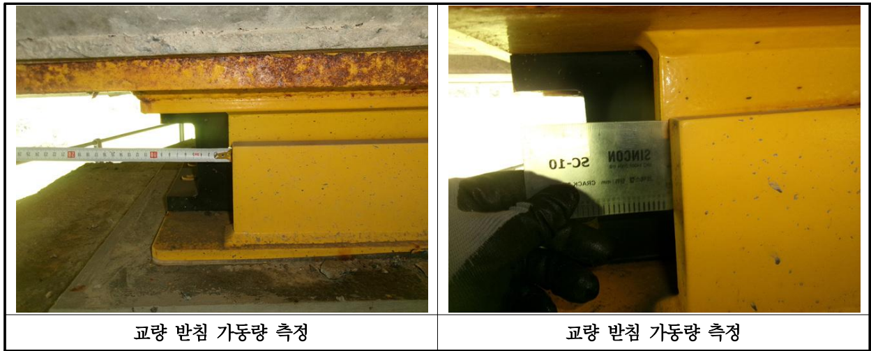
【사진 3.3.18】교량받침 이동량 측정
