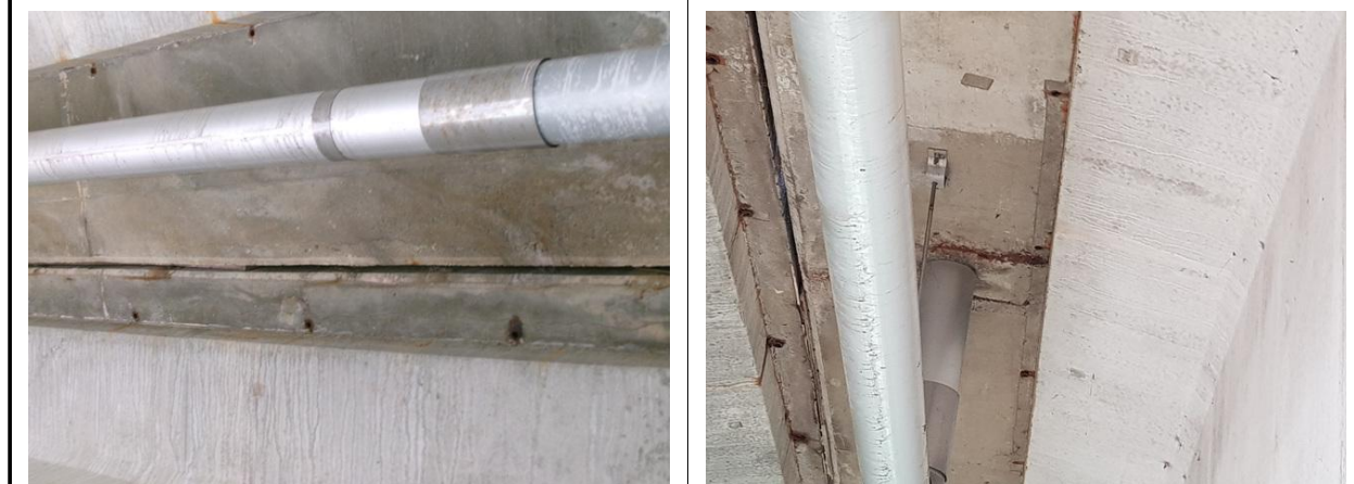
중분대 하면 상태양호
