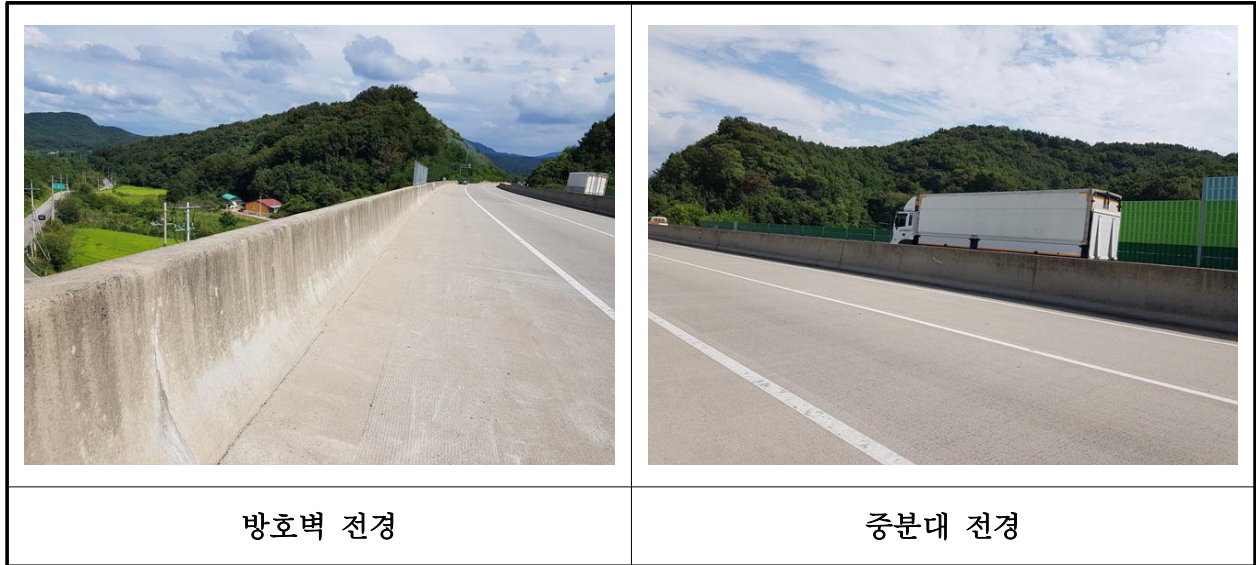
【사진 3.3.26】 방호벽 및 중앙분리대 전경
