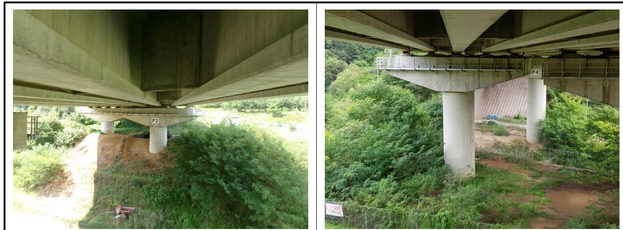
교각 코핑부 상태양호
