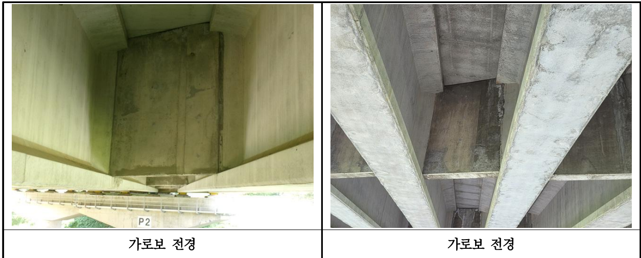
【사진 3.3.8】 가로보 전경
