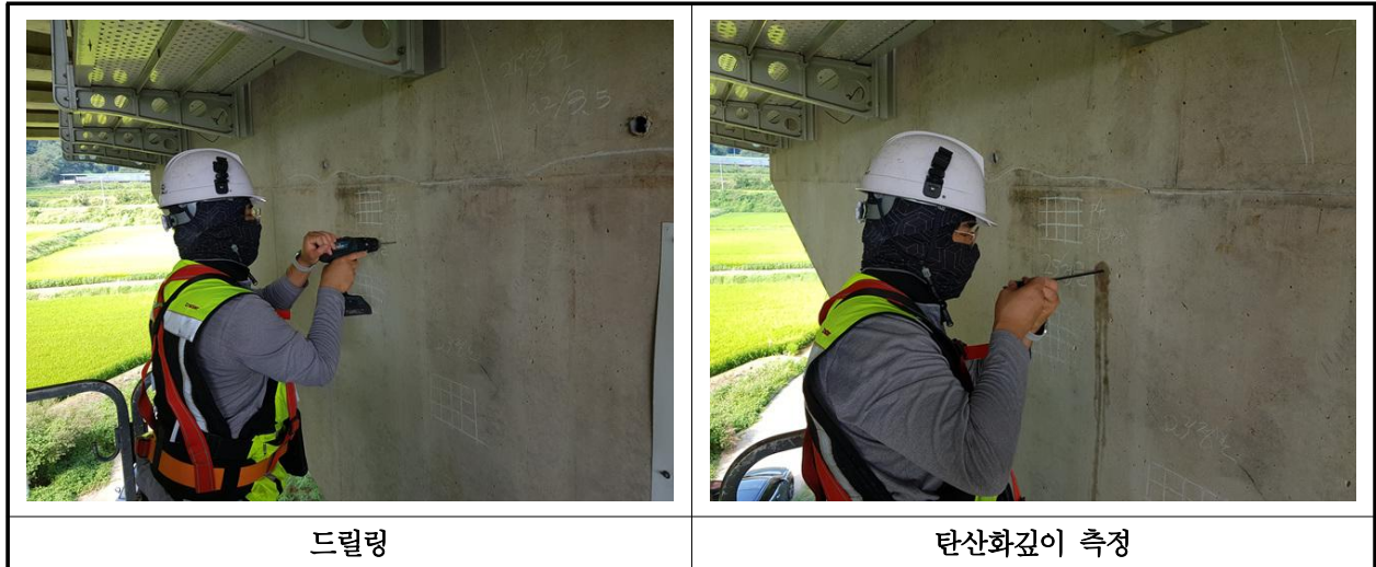
【사진 3.4.3】 탄산화 깊이 측정 현장사진
