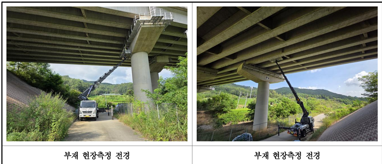
【사진 3.2.1】 부재 현장측정 전경
