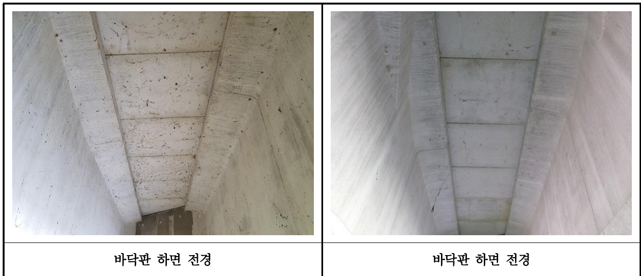
【사진 3.3.4】 바닥판하면 전경
