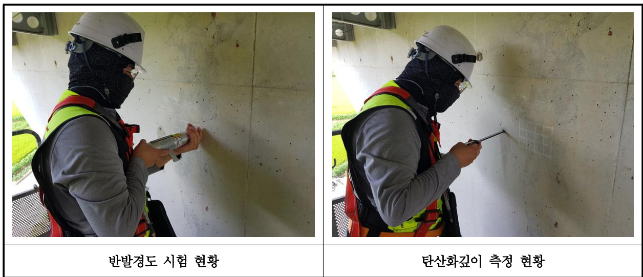
【사진 3.4.1】 콘크리트 내구성조사 현황
