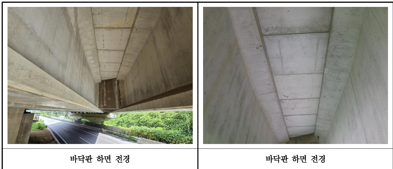
【사진 3.3.31】 바닥판하면 전경
