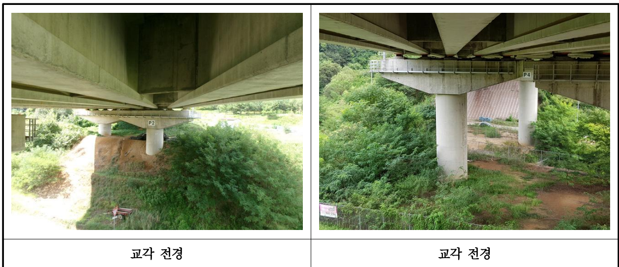
【사진 3.3.12】 교각 전경
